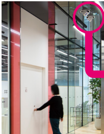
高さ約3.5mの天井から2箇所(ドアノブとタッチパネル)をUV照射
